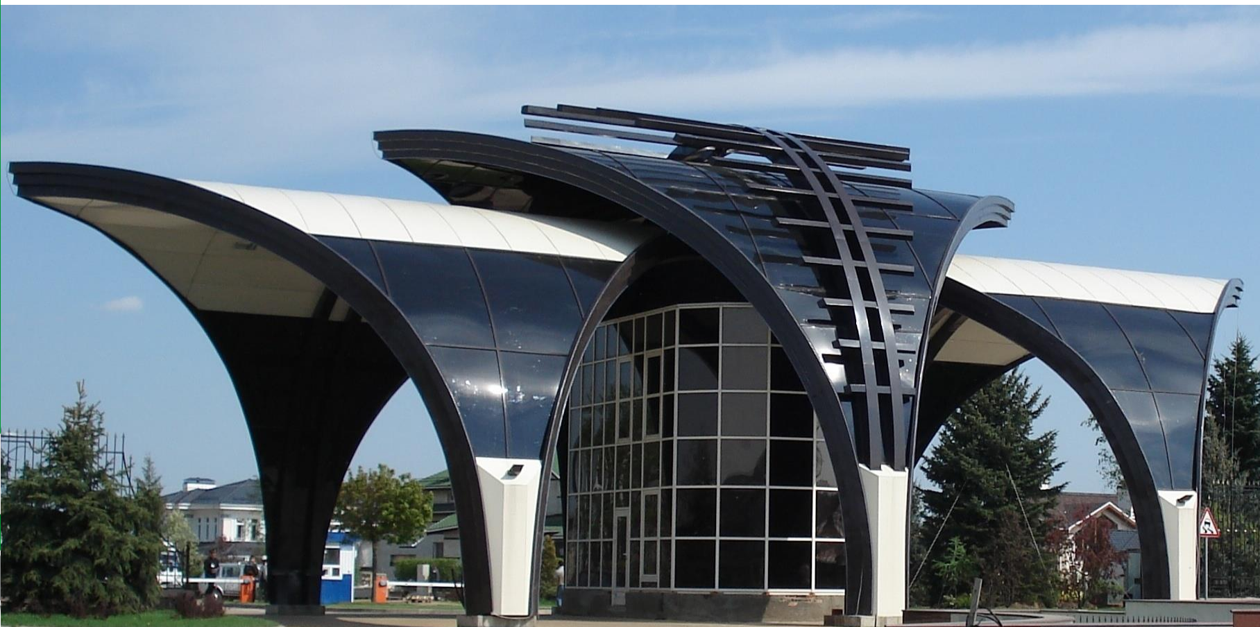
КПП коттеджного поселка в г. Тула монолитный поликарбонат, цвет бронза Т 25%, толщина 6мм
